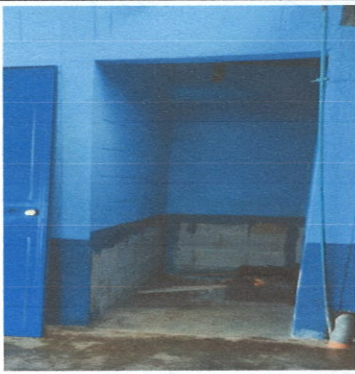
Foto 2: Pared finalizado en el interior de la dirección conduciendo una puerta
