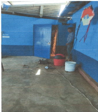
Foto 4: Puerta final en el interior
