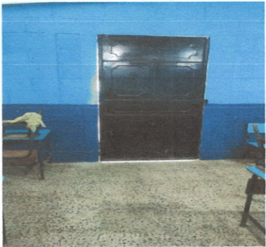
Foto 5: Puerta Final hacia patio de descanso
